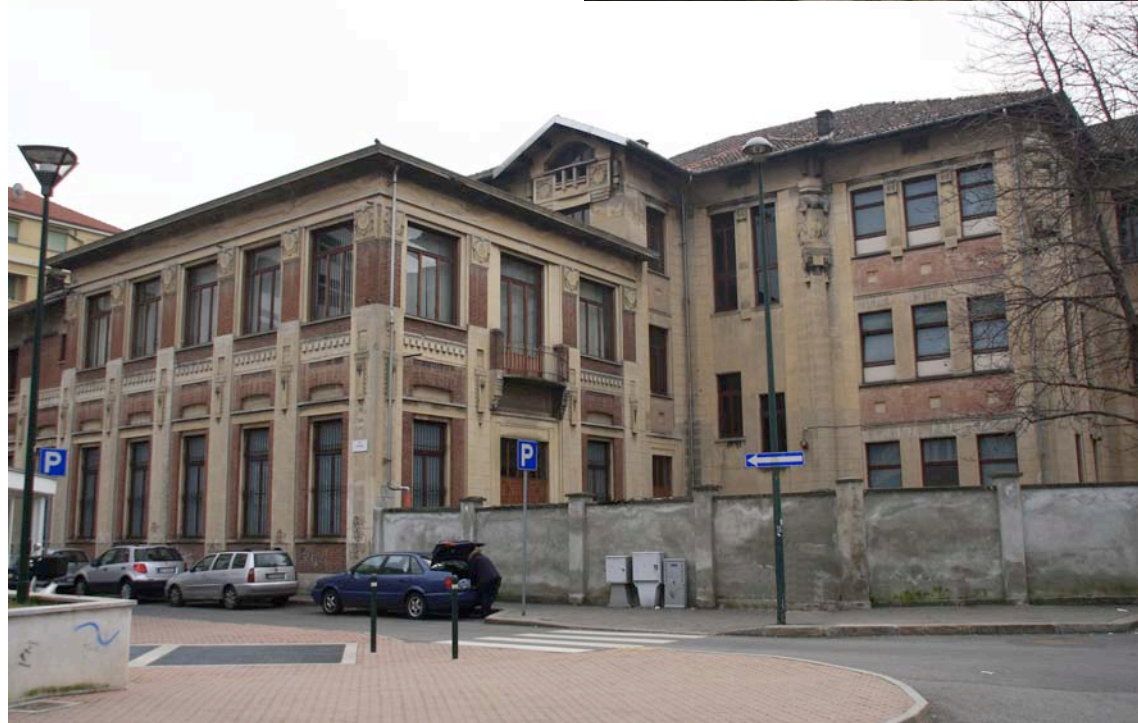
Via F. Galvagno - Via San Paolo - Scuola Elementare Santorre di Santarosa
