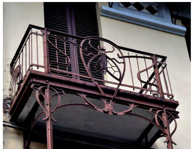
Foto 15: Particolare balcone con insetto in ferro battuto
