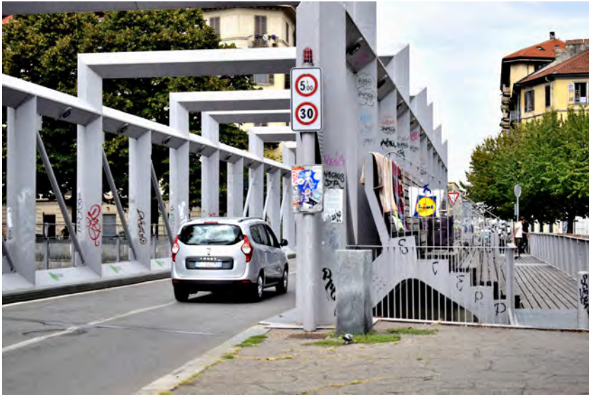
Foto 6: Via Borgo Dora 61 ponte carrabile strutture in ferro, panchine al sole sulla dora
