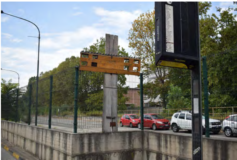
Foto 2: Corso Regina Margherita 400 Thyssenkrupp, Fronte Parco Pellerina
