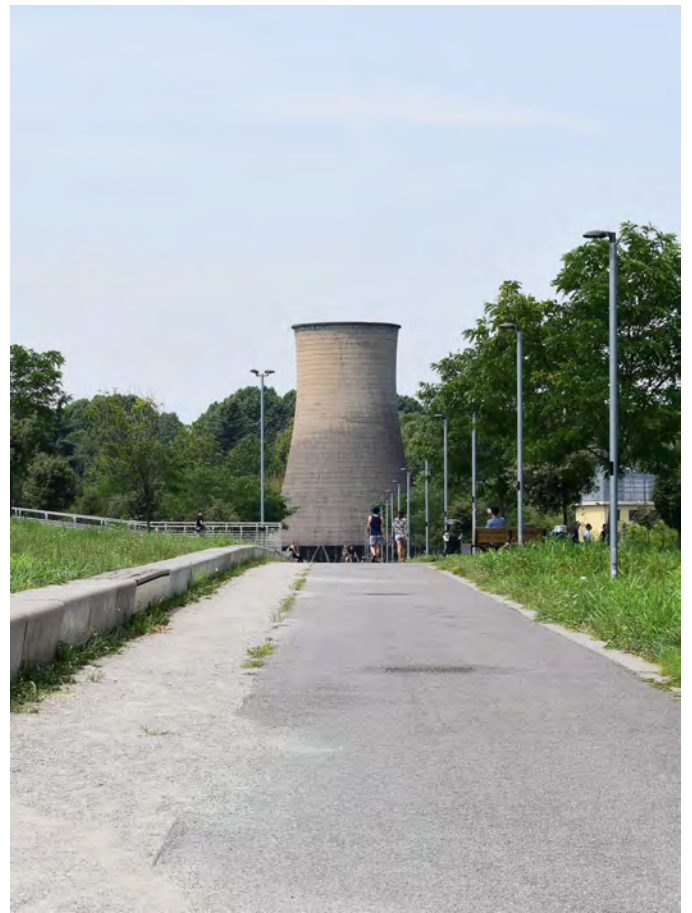
Foto 4: Parco Dora Corso Umbria torre di raffreddamento
