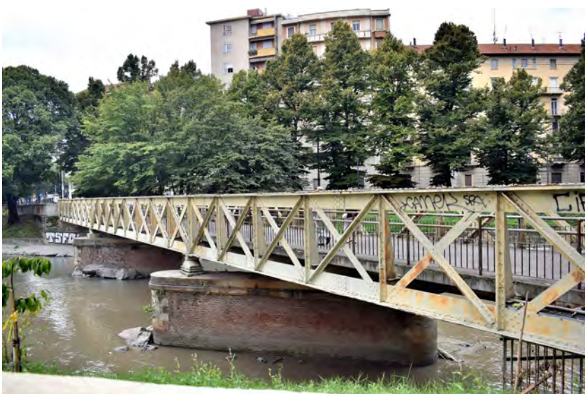
Foto 8: Lungo Dora Firenze 21 Bis Ponte Pedonale in ferro
