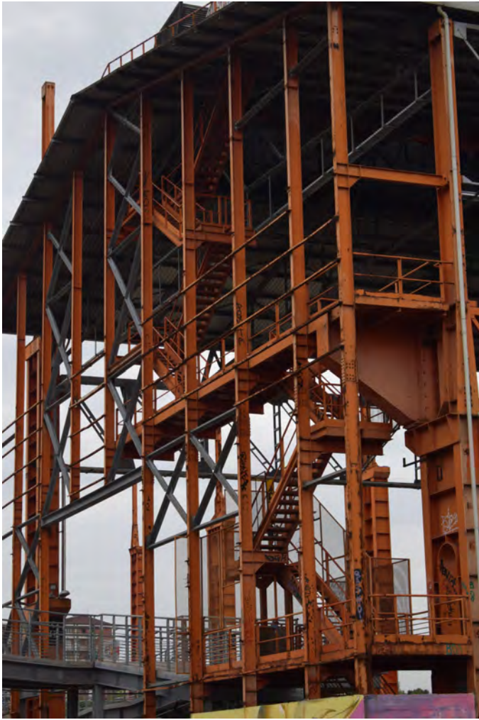
Foto 3: Parco Dora Via Borgaro 7-15 scheletro di capannone industriale
